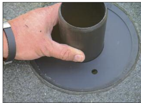
Abflusswächter: Je nach gewünschter Entschleunigung der Entwässerung verfügt SitaRetention Fix über eine oder mehrere Bohrungen.
