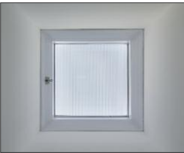
Für die Umkleidekabinen: Die LK classic als PC-st Ausführung mit sehr guten Ut-Werten und optimaler Lichtstreuung.
