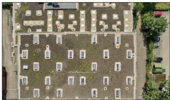
Das Dach wurde neu gedämmt sowie abgedichtet und mit einer extensiven Dachbegrünung versehen. Für die natürliche Belichtung der großen Halle sowie der Nebenräume wurden Oberlichter verbaut.
